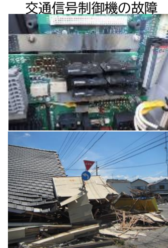
交通信号制御機の故障 道路標識の損壊
