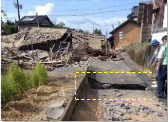
幹線水路の破断（氷川町）
