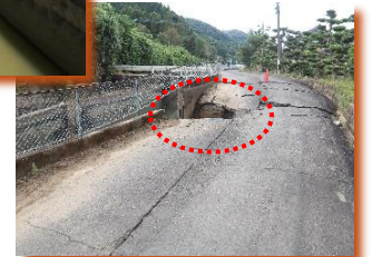
不知火幹線水路の 崩壊（八代市）
