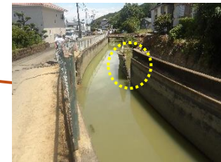
不知火幹線水路の 崩壊（八代市）
