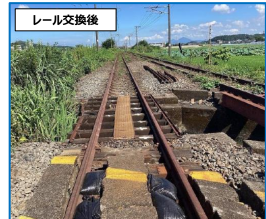
【松橋・小川間】損傷レール交換
