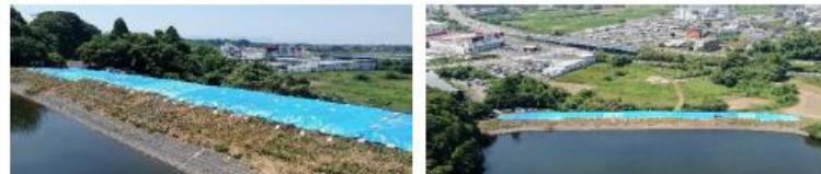
ため池堤体の応急処置（シート張り）
