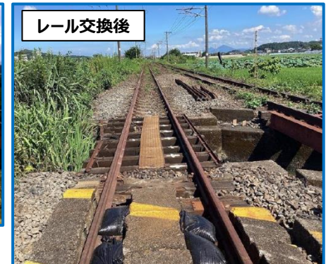
【松橋・小川間】損傷レール交換
