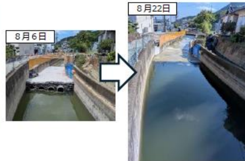
追加工事により送水量を増量
