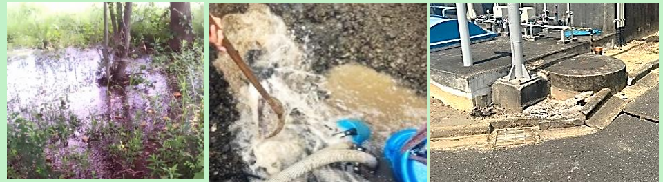
工業団地内（漏水） 八代市郡築（漏水） 白島浄水場（地盤沈下）
