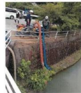
給水車用の 応急取水ポンプ設置
