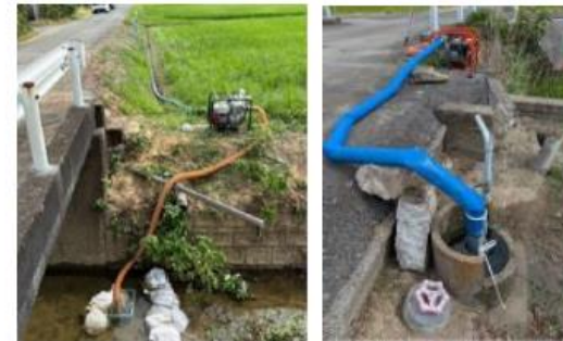
応急的な取水のため用水路の充水
