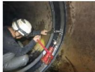
幹線水路の管内面補修状況
