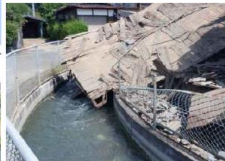
水路への建物の倒壊
