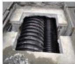
幹線水路の仮復旧状況
