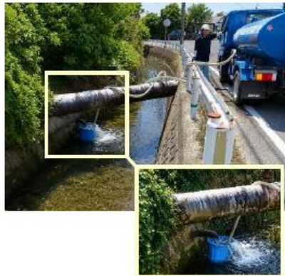
幹線水路の落水を取水
