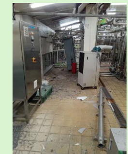
▲熊本県酪連熊本工場の損壊（熊本市）
