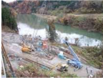
地すべり対策工事の実施
