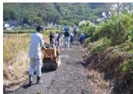
農道のアスファルト舗装
