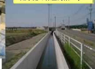
用水路の保全対策工事
