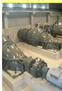
排水ポンプ等の更新整備 (イメージ)
