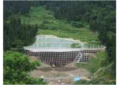
地すべり対策工事の完了
