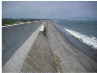
堤防整備状況
