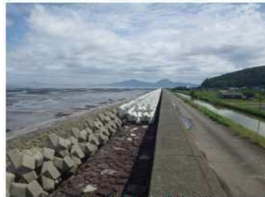
消波ブロック整備状況
