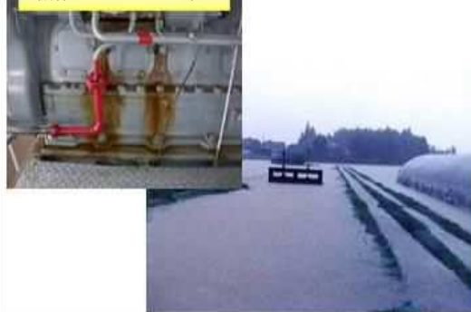
機器からのオイル漏れ
