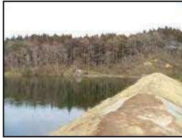
改修前のため池
