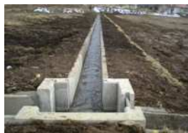
コンクリート水路への更新
