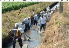
水路の泥上げ
