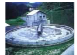
畜産環境対策施設
