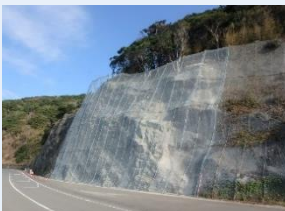
国道389号落石防護網工(天草市)
