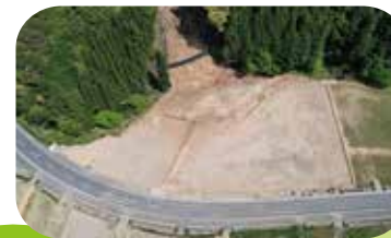
農地の復旧（芦北町宮浦地区）
