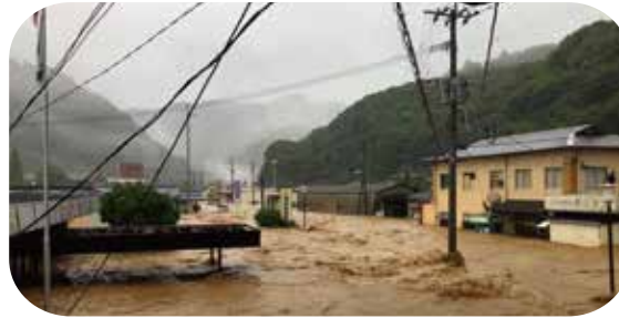
はんらん 川が氾濫した八代市坂本町
