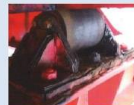
【港湾】可動橋(長洲港)の補修
