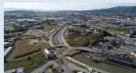
【流域治水】潤川(宇土市)の整備
