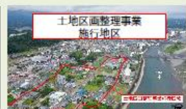
土地区画整理事業 施行地区 区画整理(人吉市青井地区)
