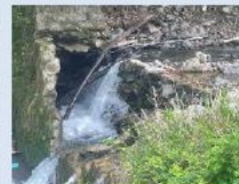
【砂防】砂防堰堤(球磨村)の補修
