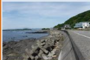
【道路】国道324号での越波対策工
