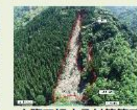
山腹工による対策箇所 (球磨村)
