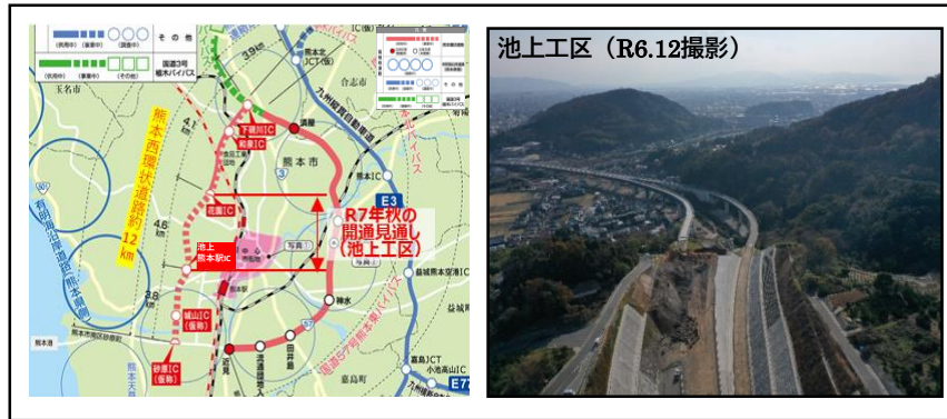
熊本西環状道路の状況【熊本市】
