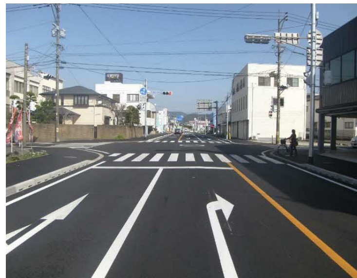
国道266号（松橋交差点）の改良
