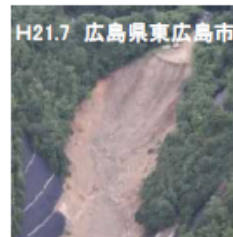
廃棄された土石の崩落
