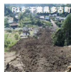
廃棄された土石の崩落
