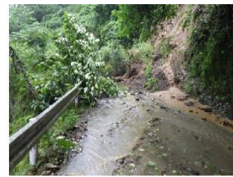
⑩林道の法面崩壊(五木村)
