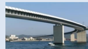
【漁港】牛深ハイヤ大橋橋梁の補修
