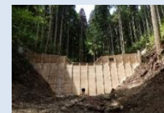
【森林】治山ダムの設置
