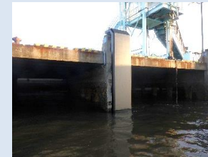
【港湾】熊本港(熊本市)大型防舷材補修
