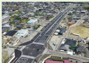
益城中央線(益城町)の整備
