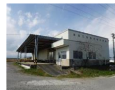
冷蔵冷凍施設
