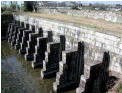
旧郡築新地甲号樋門(八代市)
