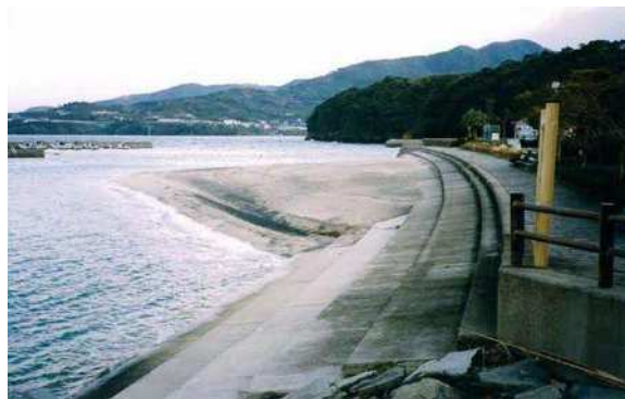
緩傾斜護岸(湯の児海岸)
