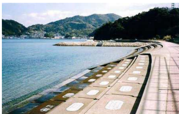
緩傾斜護岸(上天草港海岸)
