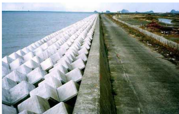
堤防(消波工)(金剛海岸)
