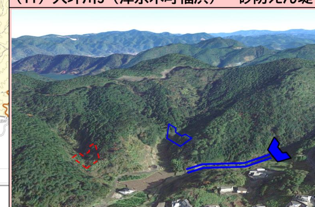
(11) 大坪川3 (津奈木町福浜) 砂防えん堤
