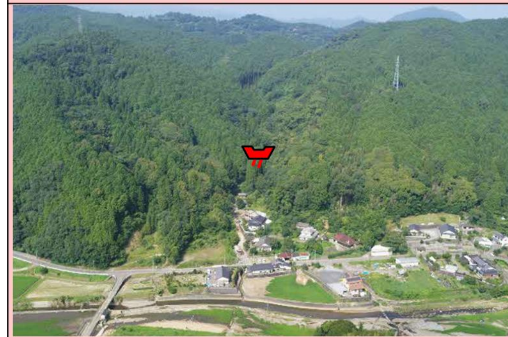
(6) 管無田川 (芦北町桑原) 砂防えん堤
