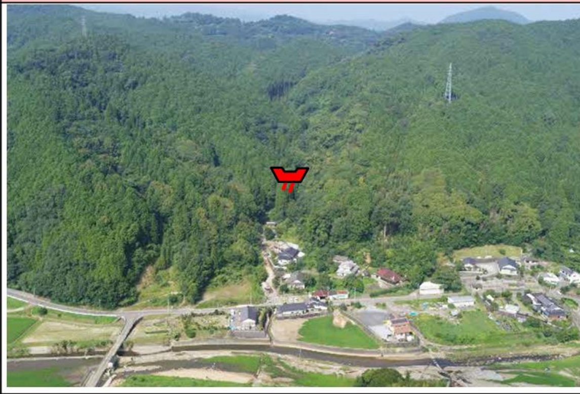
⑦ 赤江川-1 (芦北町田川) 砂防えん堤
