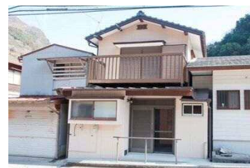
空き家を改修した移住者用住宅
