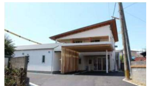
H25年度に設備されたケアホーム
