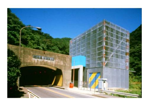
跨越熊本县与宫崎县的县境、国道 221 号的环形桥,即可看到加久藤隧道。 本建筑物是收纳用于隧道内换气的气泵、进气口的设施。
