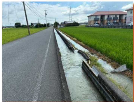
水路破損による通水不能 【八代市・氷川町全域】
