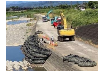
氷川（氷川町）応急工事
