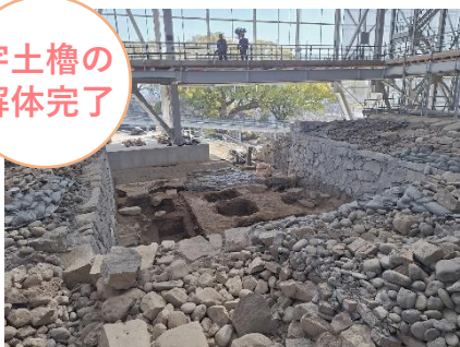
解体が完了した宇土櫓
