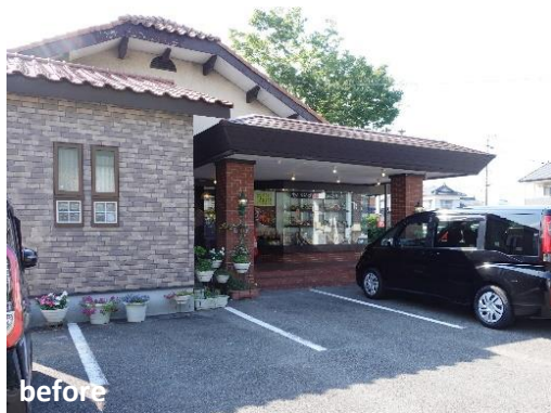
●車いす利用者用駐車場の整備
