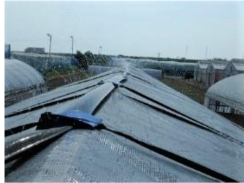
屋根散水の設置状況 (遮光資材はふわふわSL40を使用)
