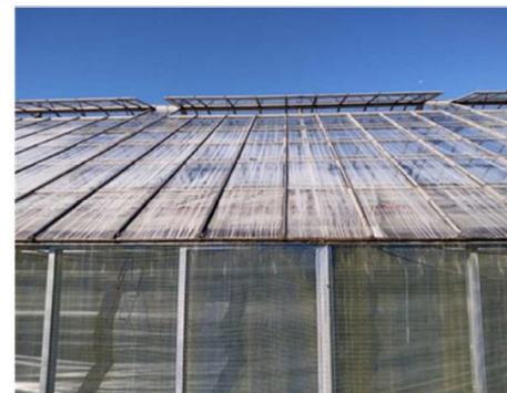
屋根型ハウスでの塗布剤の使用例
