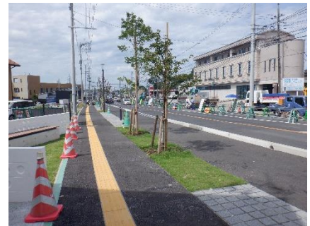
（都）益城中央線 植栽状況
