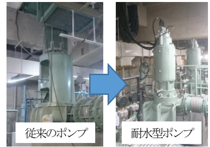
災害復旧と併せて、下水処理場地下のポンプを耐水化（人吉市）
