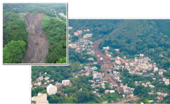
(静岡県熱海市で大雨に伴って盛土が崩落し、土石流が発生した状況(令和3年7月))
