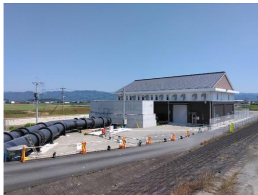
金剛排水機場（八代市）
