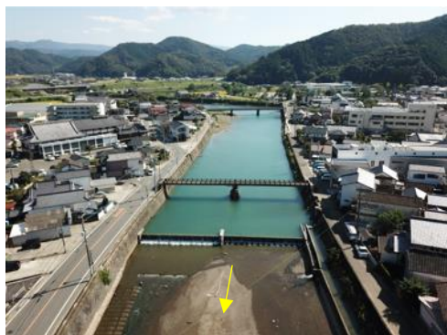
写真 1.22 堰に設置された魚道 (無名堰 1 号)
