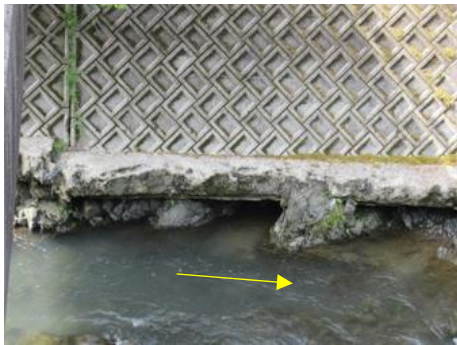
写真 2.5 巡視で確認された護岸欠損箇所
