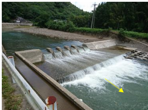
佐敷川の農業用水取水堰（内田堰）
