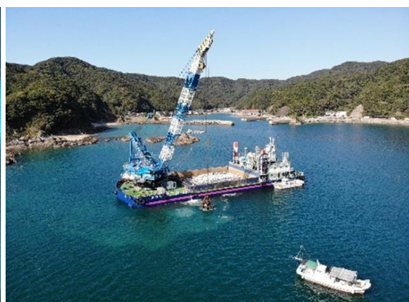
図4-3-7 藻場造成工事（投石）状況 (天草市軍浦)
