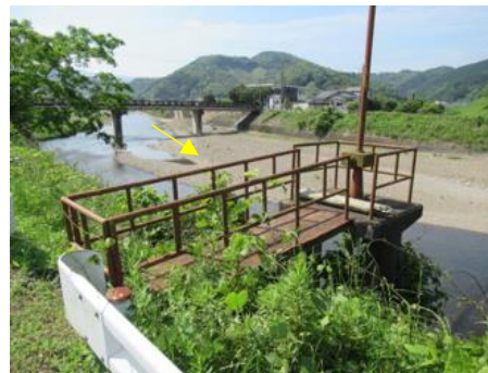
写真 2.6 老朽化した樋管
