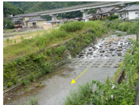
写真 1.23 取水堰(緩傾斜型)
