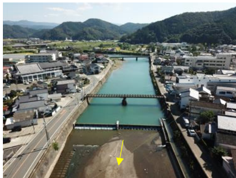
写真 1.22 堰に設置された魚道 (無名堰 1 号)
