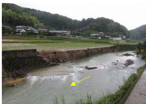
⑧ 田川川護岸の被災状況
