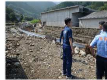
越水土砂流出被害 (美里町)
