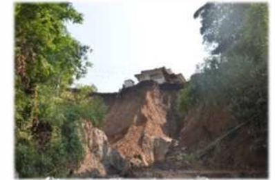
急傾斜崩壊被害 (美里町)
