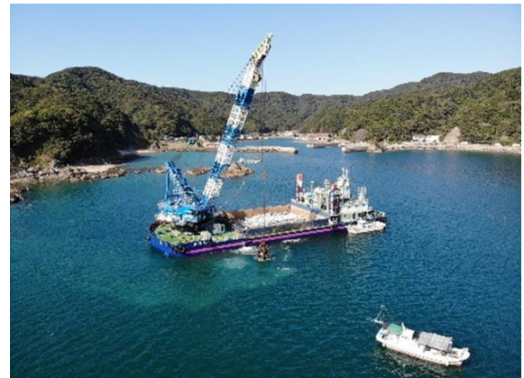
図4-3-7 藻場造成工事（投石）状況 (天草市軍浦)
