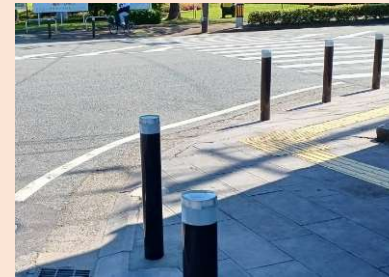
車両侵入防止ポール(八代市)
