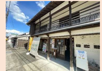
空き家をこどもの学習スペースとしても利用 可能な交流施設に改修した例(多良木町)
