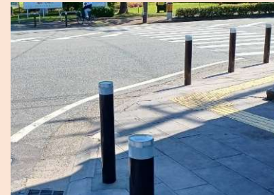
車両侵入防止ポール(八代市)
