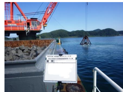
藻場造成工事(投石)状況 (R6.6 天草市牛深)
