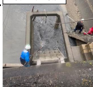
フラッシングの状況
