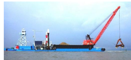
覆砂工事状況(R6.5 荒尾市)
