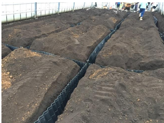
写真 1 波板設置の様子
