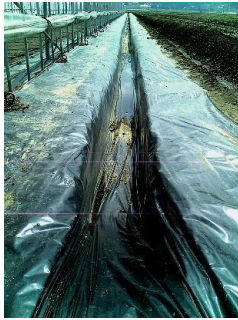
【ハウス周辺の排水溝】
