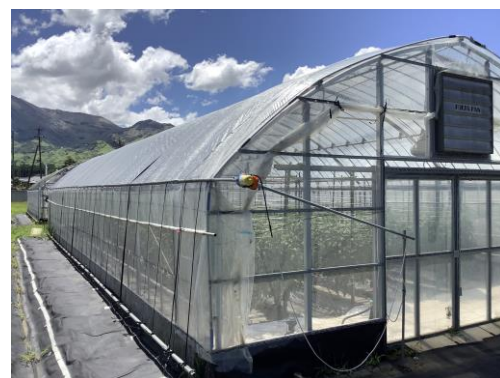
外張りの自動開閉装置
