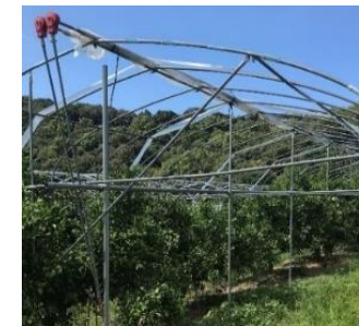
かんきつ簡易ハウス
