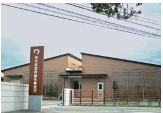
熊本県食肉衛生検査所 (R2.11 完成)
