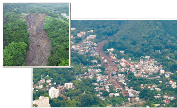
静岡県熱海市で大雨に伴って盛土が崩落し、土石流が発生(令和3年7月)
