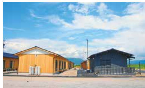
熊本地震で整備した応急仮設団地(阿蘇市北塚(木造))
