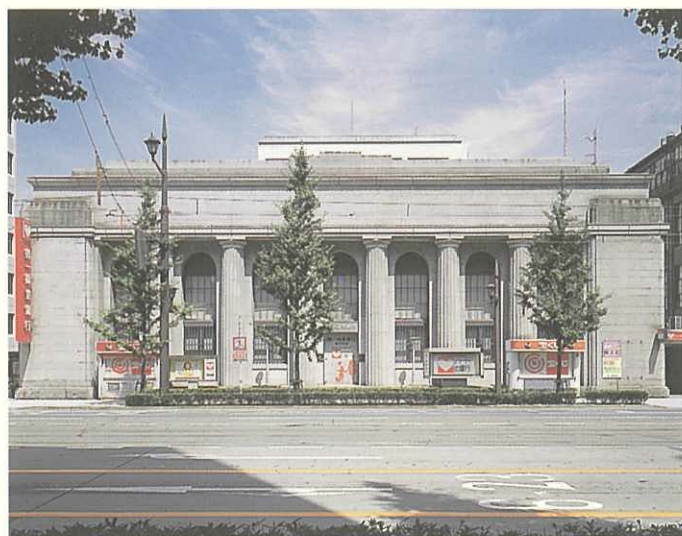
第一勧業銀行熊本支店 熊本市
