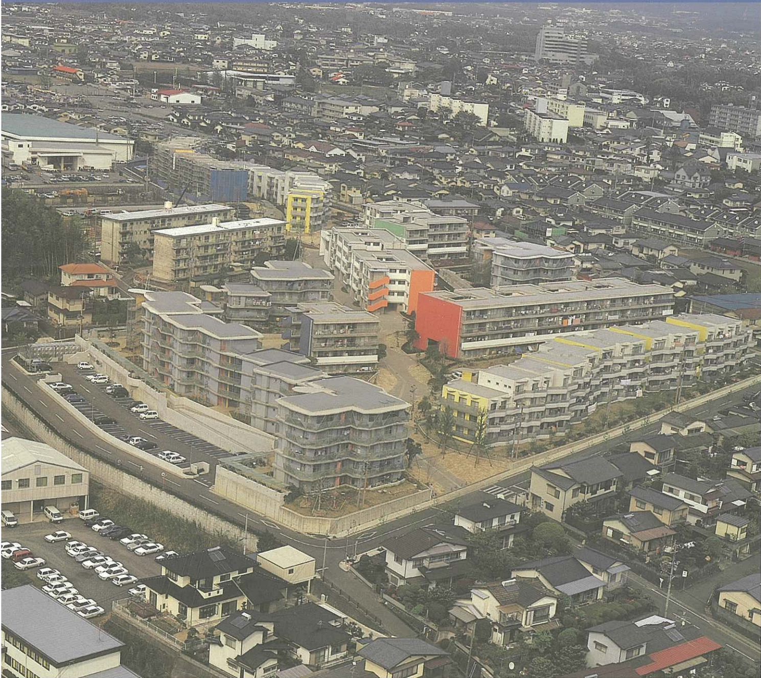
熊本市営託麻団地
