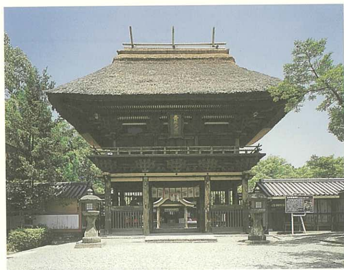
青井阿蘇神社(楼門、本殿、幣殿、拝殿) 人吉市
