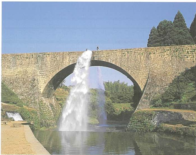
通潤橋 矢部町
