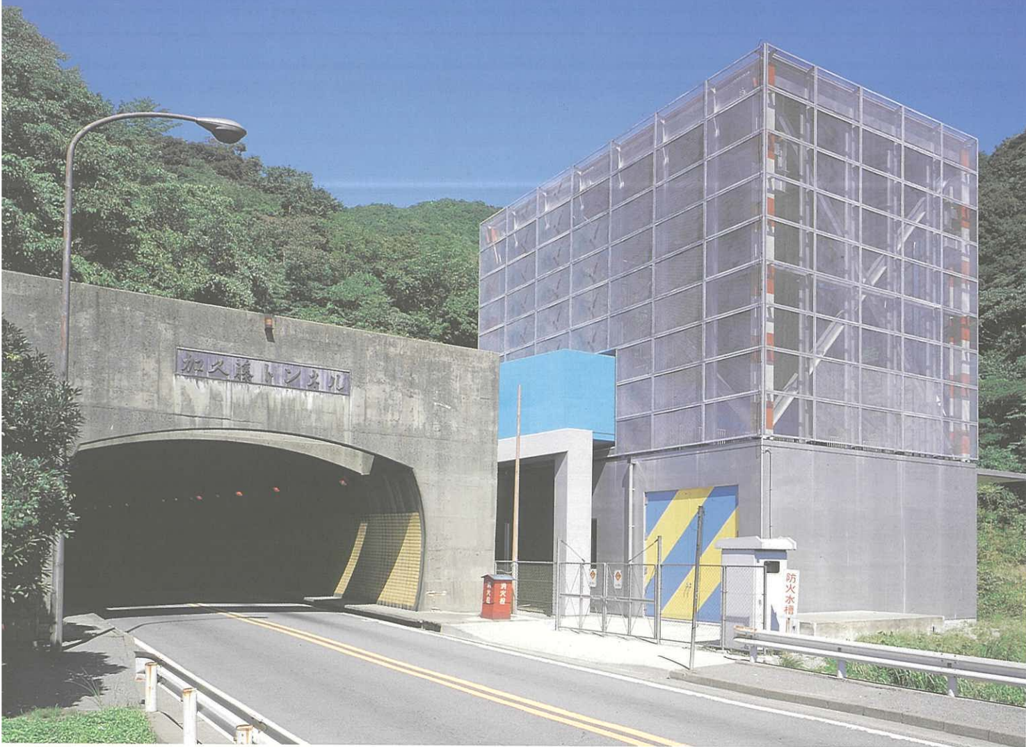
加久藤トンネル換気所 小山 明+パシフィックコンサルタンツ
