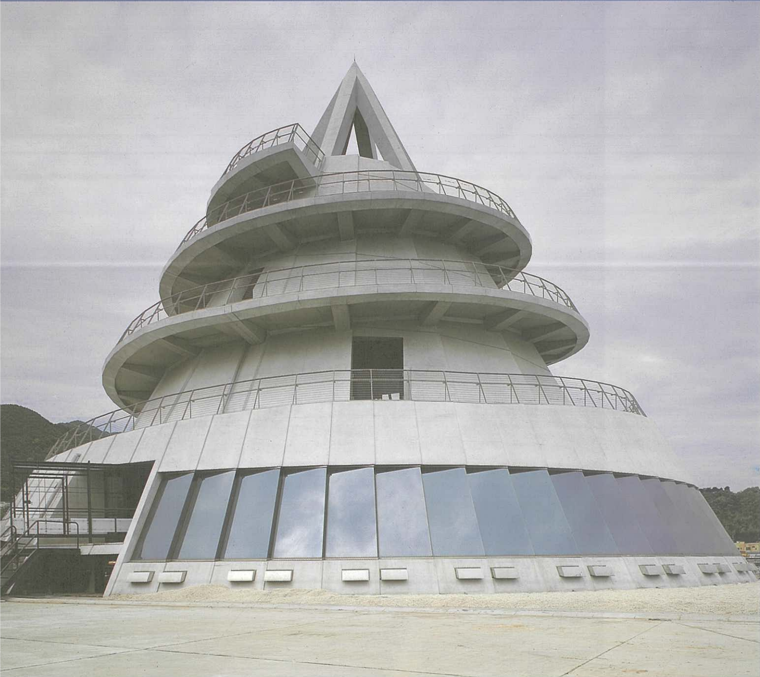
三角港フェリーターミナル
