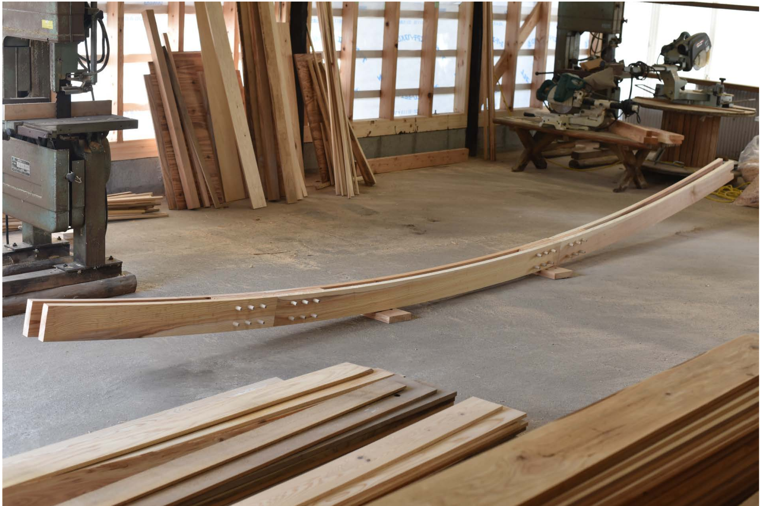
湾曲梁の組み立て
