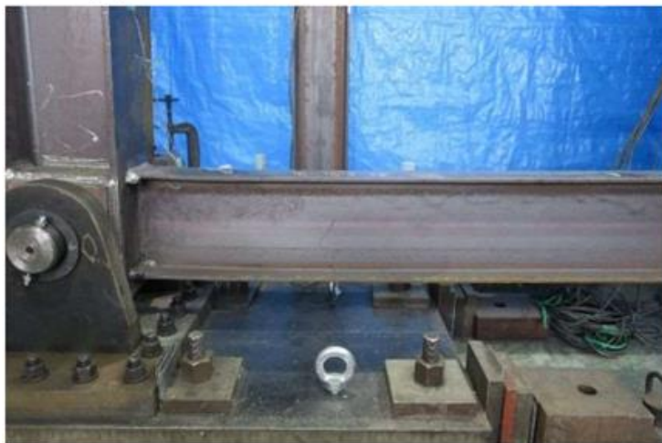
(4)最大変形時 下梁端部
