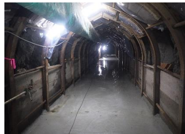
<美里地区 用水トンネル整備中>
