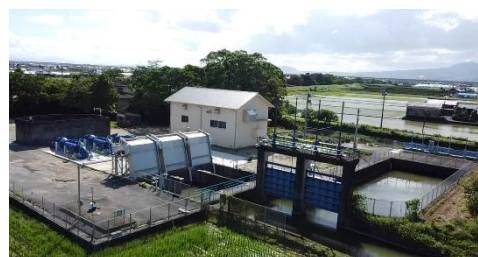
<益南排水機場（R6.5 月供用開始）>
