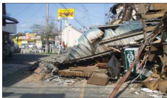
熊本地震時に道路が塞がれた状況（益城町）
