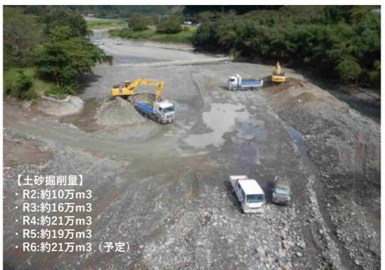
写真6 市房ダム流入土砂の除去工事状況
