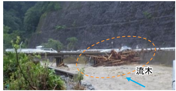
写真4 柚木河内地区の橋梁の様子 (R2.7月)
