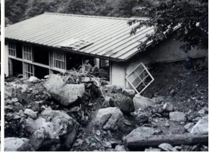
五木村横手谷の大崩落(S38.8集中豪雨) 約230万m 3 の土砂が流出
