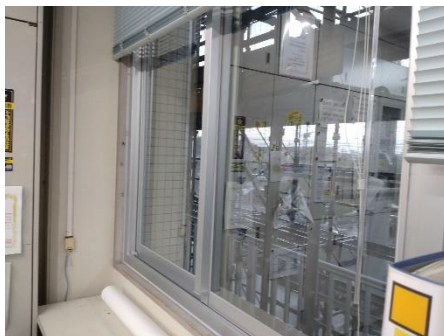
断熱性がある窓・サッシに改修
