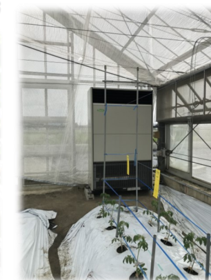
ヒートポンプ高度利用技術の開発
