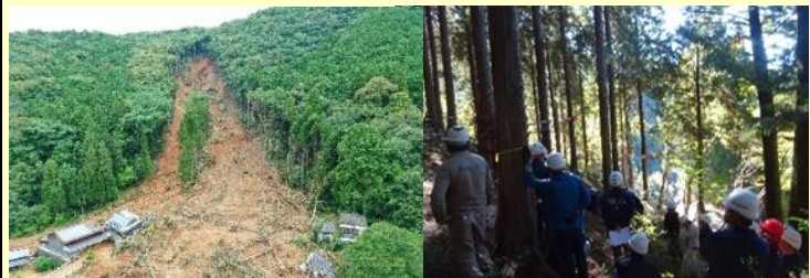
R2年7月豪雨被災状況
