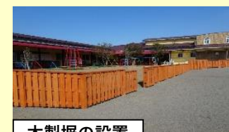
木製塀の設置
