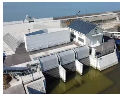
排水機場(豊川中央) R3.7月供用開始 排水能力 8.7m 3 /s
