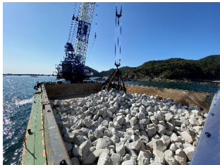
図5 自然石の投入
