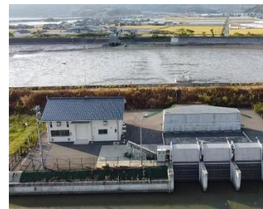
排水機場(豊川北部) R1.7月供用開始 排水能力 8.4m 3 /s
